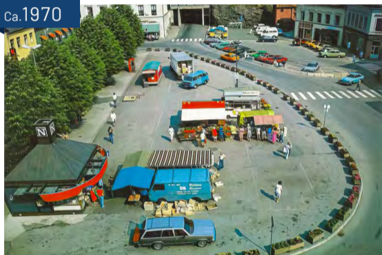
Hovedveien gikk gjennom sentrum, tvers over torvet, gjennom tunnelen til jernbanen inntil veien ble omlagt med øst- vest tunnelen i 1995. Kilde og colorering: facebook-Rudebilstasjonen i Arendal
